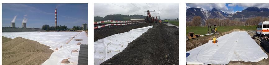
**TECNOGEO TP** trouve des applications dans les sous-couches des constructions routières et ferroviaires ainsi que dans les renforcements de talus en terre.
