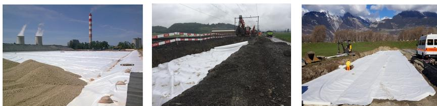
**TECNOGEO P** trouve des applications dans les sous-couches des constructions routières et ferroviaires ainsi que dans les renforcements de talus en terre.
