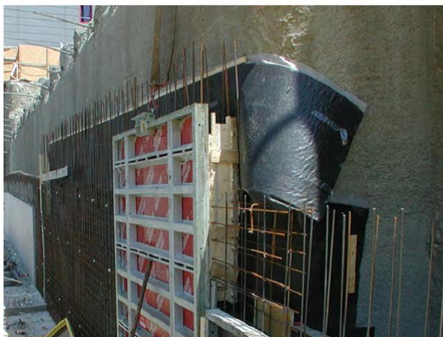
Le géocomposite ENKADRAIN CK est particulièrement indiqué dans les ouvrages enterrés. Il peut aussi être utilisé comme coffrage perdu afin de permettre de bétonner directement contre le produit côté membrane et drainer côté géotextile.
