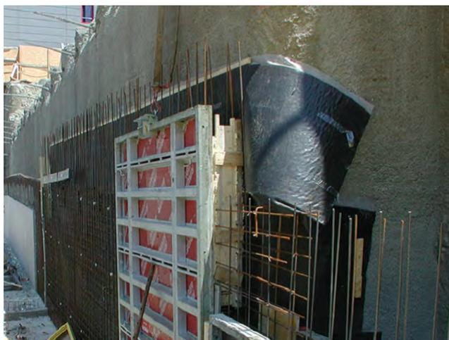
Le géocomposite ENKADRAIN CK L est particulièrement indiqué dans les ouvrages enterrés. Il peut aussi être utilisé comme coffrage perdu afin de permettre de bétonner directement contre le produit côté membrane et drainer côté géotextile.
