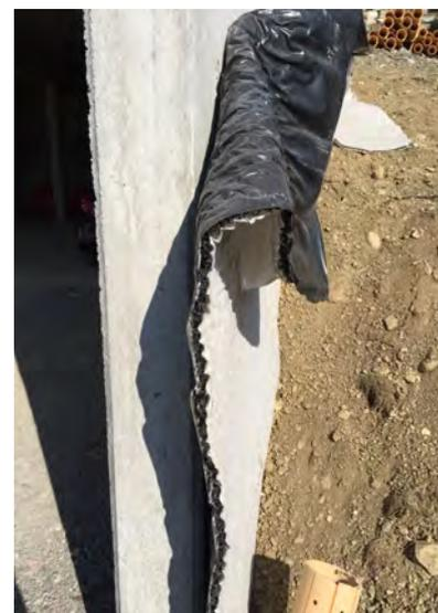
Le géocomposite **PAVIDRAIN 2F20 L PL** est particulièrement indiqué dans les ouvrages enterrés. Il peut aussi être utilisé comme coffrage perdu. Il permet aussi de bétoner directement contre le produit côté membrane et drainer côté géotextile.
