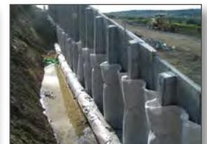
Le géocomposite **PAVIDRAIN** est particulièrement indiqué dans les toitures végétalisées et dans les ouvrages enterrés. Il peut aussi être utilisé dans les constructions en terre renforcée, dans les ouvrages hydrauliques, les galeries et les décharges.
