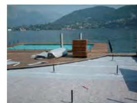
Le géocomposite **PAVIGRID** est particulièrement indiqué en tant que couche drainante dans des couvertures accessibles à haute charge, contre les parois verticales et dans la construction de décharges. Il peut être utilisé aussi dans les constructions en terre renforcée, les ouvrages hydrauliques, les galeries et les ouvrages enterrés.
