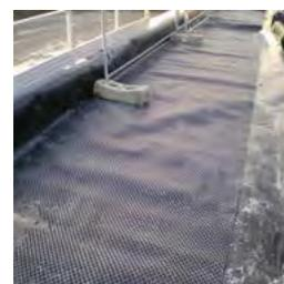
Le **NOPPENMATTE PREMIUM** est appliqué directement sur les lés d'étanchéité dans les cas où il n'est pas demandé d'autres prestations particulières à la couche protectrice. Il peut également être utilisé comme couche de compensation avant l'application d'un béton projeté.
