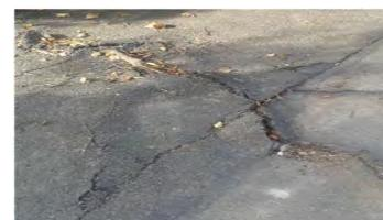
En surface l'apparition des racines provoque fissurations et rupture des revêtements des trottoirs, parkings ...
