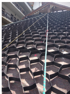
CELLULE E REMPLISSAGE
