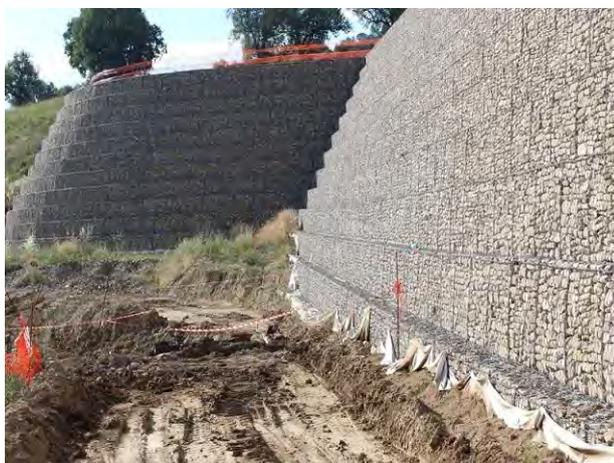
Le gabion boîte est un prisme rectangulaire en grillage métallique à double torsion avec une maille hexagonale tissée avec du fil d'acier fortement galvanisé ou en alliage zinc-aluminium et/ou en plastique polymère en fonction du degré d'agressivité de l'environnement. Le maillage hexagonal qui forme la structure est de type 8 x 10. Les gabions métalliques sont largement utilisés :
