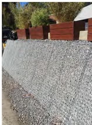
Composé de panneaux treillis électrosoudés à haute résistance, liaisonnés par des spirales multi-vrilles, **MC GABIONS®** présente de nombreux avantages, tant architecturaux que de résistance.
