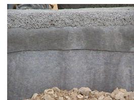
**GEOTEX RC** est indiqué pour la protection des étanchéités dans les fondations, les décharges et les bassins. Mis en place sur des gazoducs et des oléoducs, il permet de garantir une certaine protection contre des éléments extérieurs.
