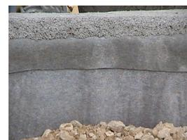
**STRATUM P** est indiqué pour la protection des étanchéités dans les fondations, les décharges et les bassins. Mis en place sur des gazoducs et des oléoducs, il permet de garantir une certaine protection contre des éléments extérieurs.
