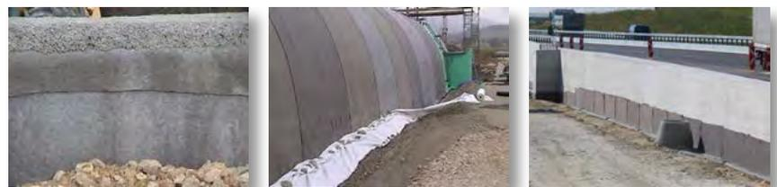
**STRATUM** wird in Kontakt mit den Abdichtungen an Fundamenten, Deponien und Becken aufgebracht. Außerdem wird es als Schutz für Gas- und Ölleitungen verwendet.
