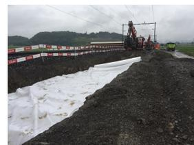
**TECNOGEO F** trouve des applications dans les sous-couches des constructions routières et ferroviaires ainsi que dans les renforcements de talus en terre.
