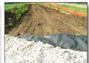
Le géotissé PAVIROCK B trouve des applications dans les constructions routières et ferroviaires ainsi que dans les renforcements de talus en terre.
