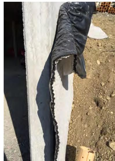
Le géocomposite **PAVIDRAIN** 2F20 L PL est particulièrement indiqué dans les ouvrages enterrés. Il peut aussi être utilisé comme coffrage perdu afin de permettre de bétonner directement contre le produit côté membrane et drainer côté géotextile.
