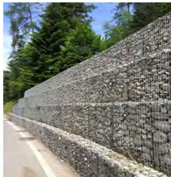
Composé de panneaux treillis électrosoudés à haute résistance, liaisonnés par des spirales multi-vrilles, **MC GABIONS®** présente de nombreux avantages, tant architecturaux que de résistance.
