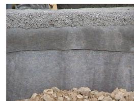
**STRATUM** est indiqué pour la protection des étanchéités dans les fondations, les décharges et les bassins. Mis en place sur des gazoducs et des oléoducs, il permet de garantir une certaine protection contre des éléments extérieurs.
