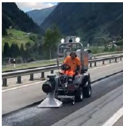
L'intervention d'un MCJETAIR sur un chantier apporte une très grande rapidité de séchage en un temps record avec des températures de séchage comprises entre 500 à 700 degrés.
