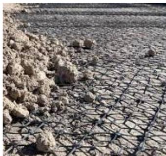
La contribution structurelle de notre géogrille est de stabiliser les couches de granulats de routes de zones de circulation ou de chemin de fer, afin de créer une couche mécaniquement stabilisée. Les granulats sont verrouillés avec la géogrille et confinés dans les ouvertures, créant un matériau composite renforcé.
